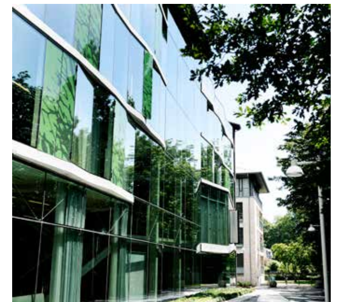
Porcelænsøen, Råvarebygningen Henning Larsen Architects (ombygning), 2009 foto: Jakob Boserup
